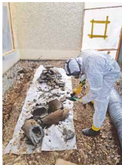
Figur 2: Dekontaminierungsarbeiten auf einer mischkontaminierten Parzelle.
