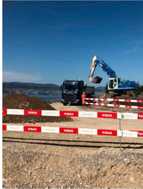
Abb. 8 Sanierung einer Deponie aus der Phosphatdüngerherstellung
