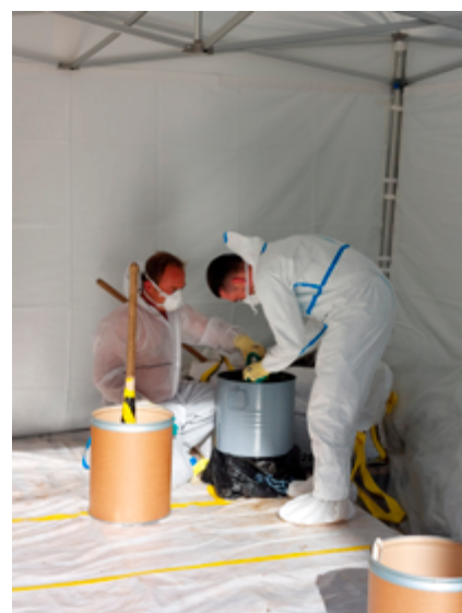
Abb. 21 Konditionierung von stark mit Radium-226 kontaminierter Erde für die Entsorgung im Bundeszwischenlager.
