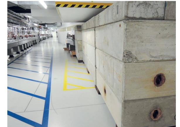
Abb. 12: Abschirmung gegen ionisierende Strahlung im Tunnel
