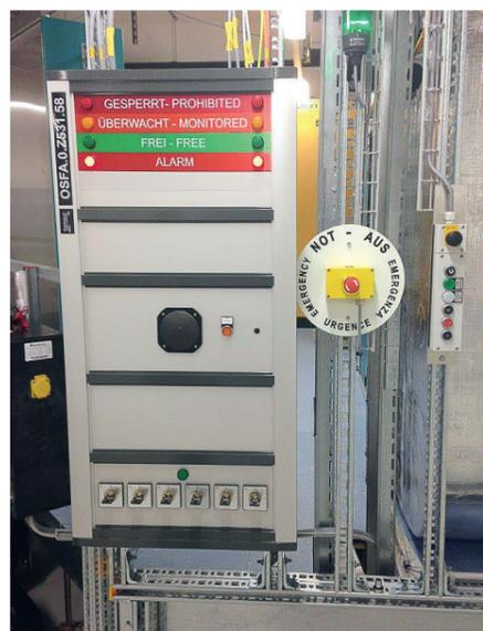
Abb. 11: Schlüsselgestütztes Personensicherheitssystem an einem der Tunnelleingänge
