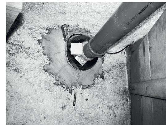
Abb. 14: Beispiel einer Leitung für die Radonabsaugung
