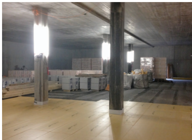
Figure 4 : Construction des laboratoires de production de produits radiopharmaceutiques à l'aide de radionucléides produits par cyclotron (le cyclotron se trouve dans un local annexe ; état au 11 avril 2013)
