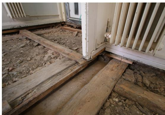
Abb. 19: Schlacken-Dämmschüttung
