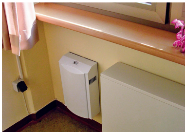
Kontrollierte Frischluftzufuhr erzeugt leichten Überdruck im Raum / Gebäude (innen und aussen).
