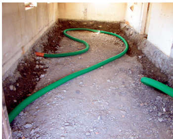
Erneuerung des Fussboden-aufbaues: Einbau einer Radondrainage.
