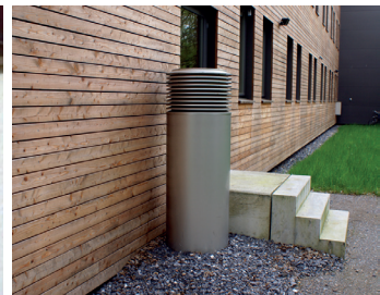
Ansaugöffnung für mechanische Zuluftanlage.
